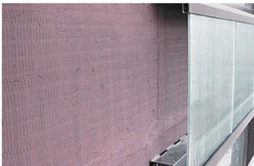
Zweischichtige Dämmplatte mit elastischer Innen- und härterer Aussenschicht als Untergrund für nachträgliche, bauseitige Farbbeschichtung. Für die Anwendung hinter transparenten Bekleidungen.
